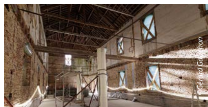
Les piliers assureront le soutien du plancher du deuxième étage pour partie
