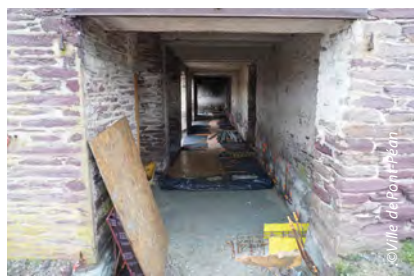
Installation du biocoffrage © et du revêtement en PVC
