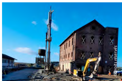
Les inclusions ont été réalisées à l’aide d’une tarière creuse
