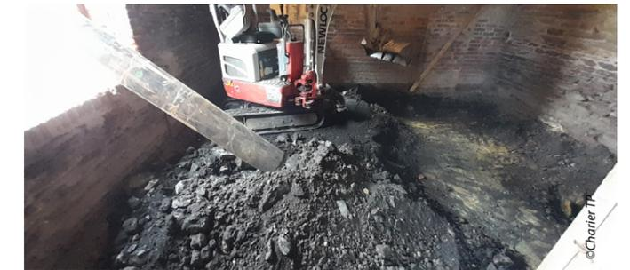
À l'intérieur du bâtiment, le dallage en béton a été démolé par les équipes de Charier TP, au marteau-piqueur pour permettre l'excavation des matériaux pollués. Une excavation sur 60 cm a été réalisée à l'aide d'une mini-pelle d'une tonne, assistée d'un camion aspirateur.
