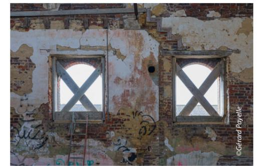
Des étréssillons en bois renforcent les encadrements de fenêtres et de portes dans l'attente de leur réfection.
