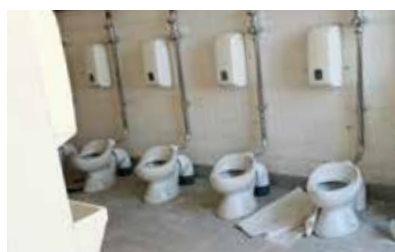
Rénovation du bloc sanitaire de la maternelle
