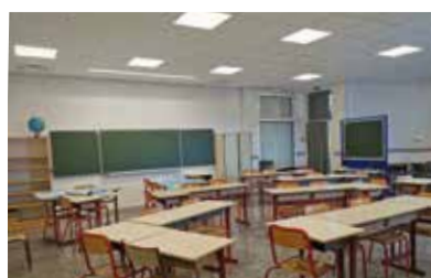
Travaux dans 3 classes avec reprise de l'isolation et pose d'éclairage LED.
