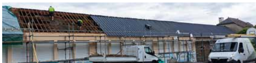
Réfection de la toiture avant la pose de panneaux solaires
