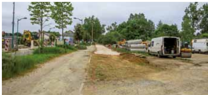
Travaux route de Nantes en juin 2016
