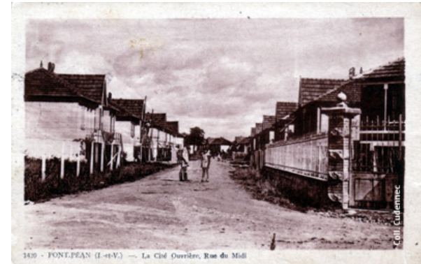
Rue du Midi : l'alignement rythmé par les toitures
