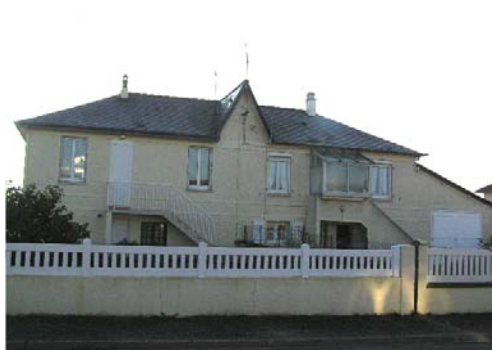
Un module de 2 maisons route de Laillé
