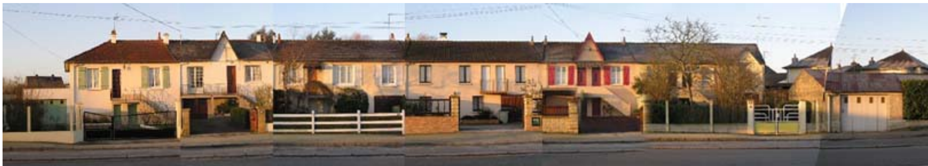
route de Nantes
